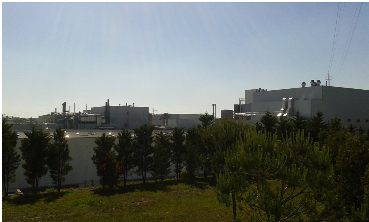
Figura 6 – Vista 2 para a cobertura da Continental Mabor
